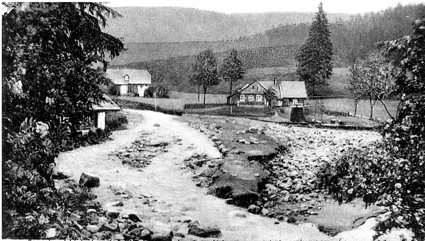
Kamenice dobývá si nové řečiště loukou a domek p. Linky, v pravo staré regul. řečiště, v levo nové.
