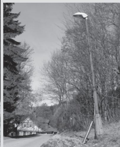
V Ryžovišti je postupně budováno nové veřejné osvětlení
