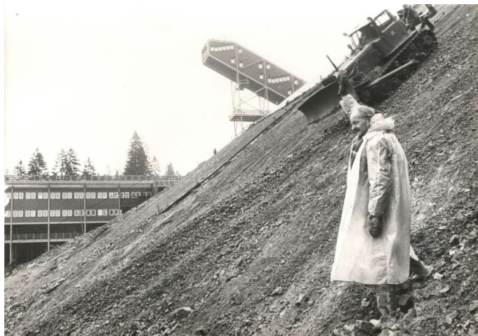
Miloslav Bělonožník na probíhající stavbě
