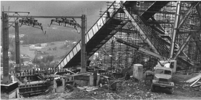
Stavba Mamutího můstku
