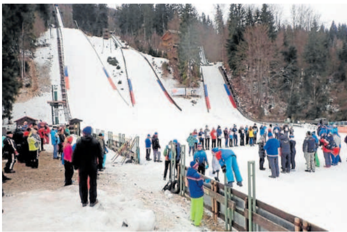
NEJISTÁ BUDOUCNOST. Můstky jsou v dezolátním stavu. Skákat se na některých dá, ale jen s velkou opatrností. Foto: MěÚ Harrachov
